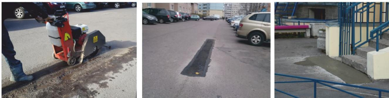
На территории ГринЛандии произведен ямочный ремонт асфальтного покрытия для предотвращения дальнейшего образования ям на асфальте. Произведено бетонирование перед подъездами, где происходил провал асфальтового покрытия. По инициативе жителей ГринЛандии, так же, как и у подъездов, у калитки со стороны техникума «Краснодеревец» были установлены две полусферы, чтобы машины не мешали проходу пешеходов.
